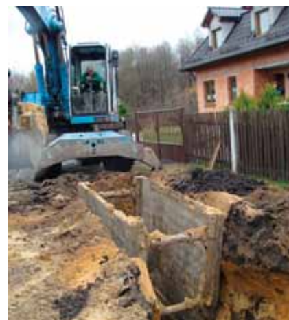
Budowa kanalizacji wraz z oczyszczalnią ścieków w Grojcu i Hucisku
