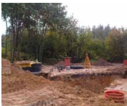
Budowa kanalizacji w Dębowej Górze
