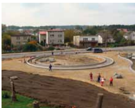
Budowa ronda w Boronowie
