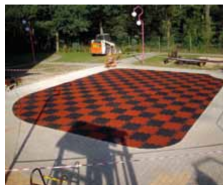
Remont placu zabaw przy ZPO
