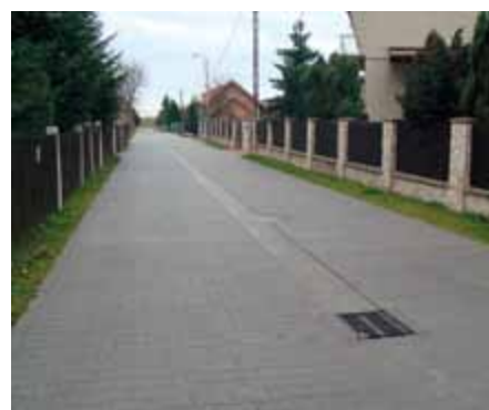
Budowa ul. Lompy wraz z odwodnieniem
