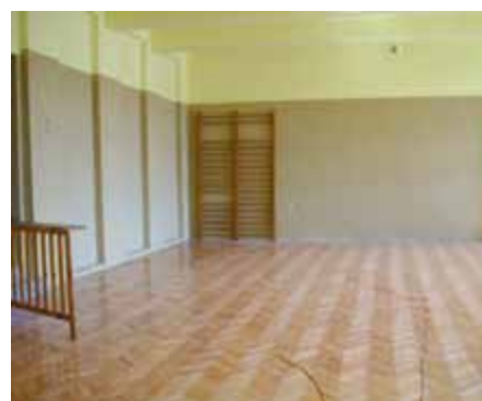
Remont małej sali gimnastycznej w ZPO
