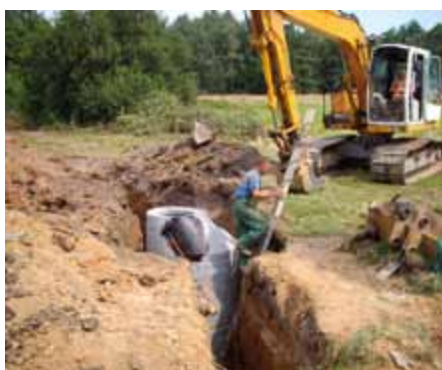
Budowa kanalizacji w Zumpach i zachodniej części Boronowa
