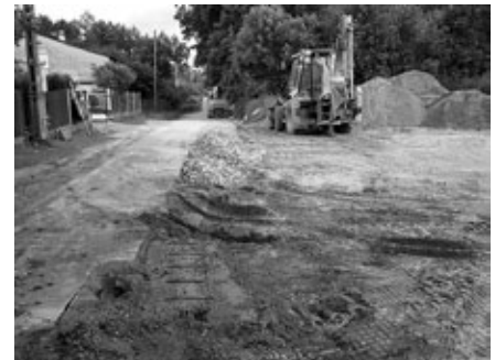
Budowa kanalizacji w Grojcu
