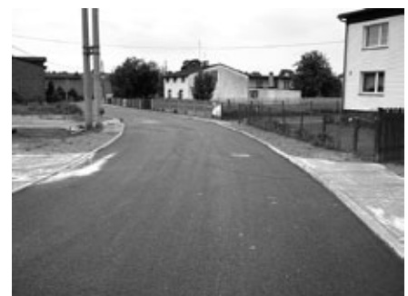
Budowa ul. Poprzecznej
