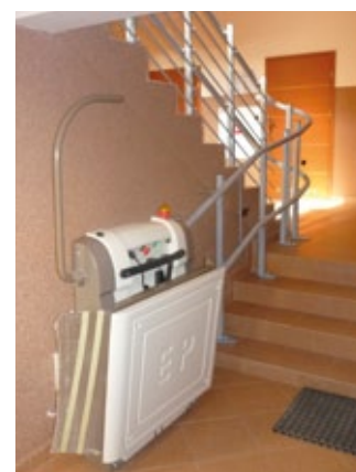
Podjazd dla osób niepełnosprawnych w odremontowanym wnętrzu GOK
