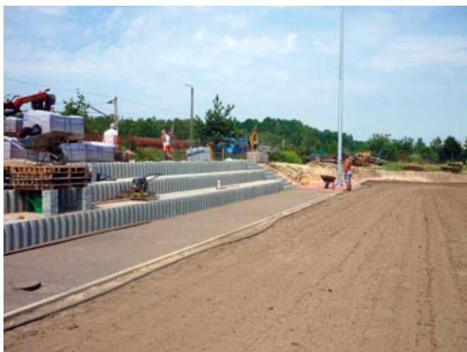
Prace przy budowie boiska LKS Jedność w Boronowie
