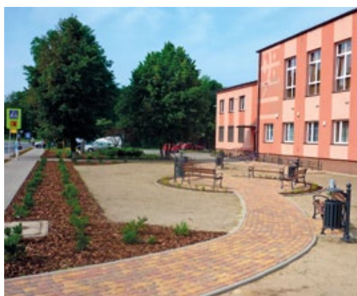
Teren przed GOK po rewitalizacji
