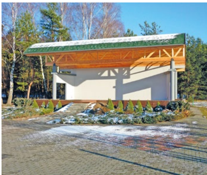
Estrada plenerowa po remoncie
