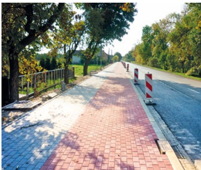
Ścieżka pieszo-rowerowa przy ul. Wolności
