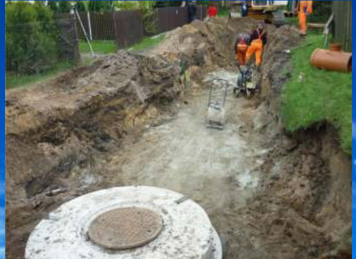
Budowa ul. Polnej, Szkolnej, Smolnej, Krótkiej
