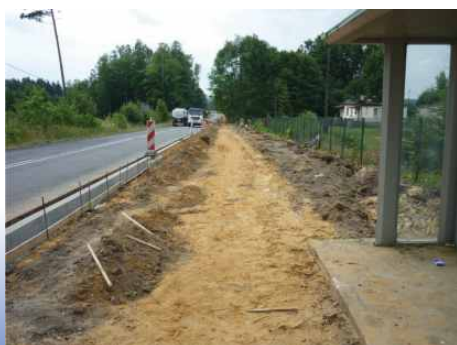
Budowa chodnika do Zumpów
