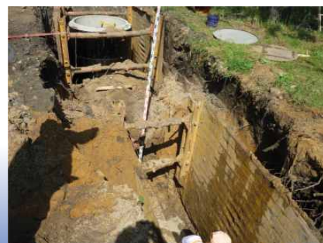
Kanalizacja na ul. Młyńskiej
