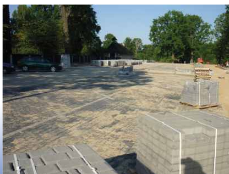
Budowa parkingu przy kościele
