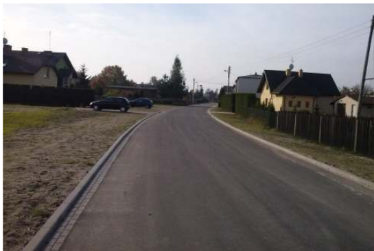
Przebudowa ulic Polnej, Krótkiej, Szkolnej i Smolnej
