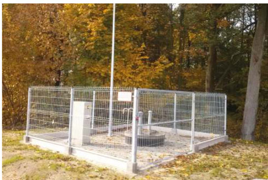
kanalizacja ul. Młyńska
