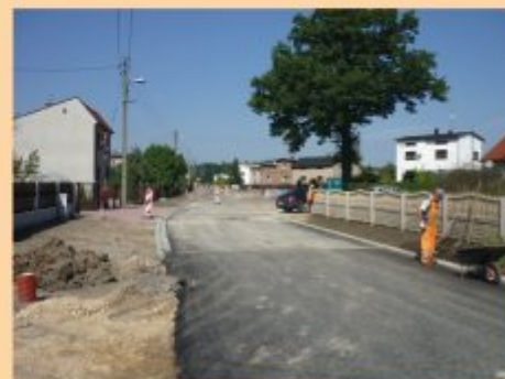
Przebudowa nawierzchni wraz z odwodnieniem ulicy Powstańców Śl. oraz ulic przyległych
