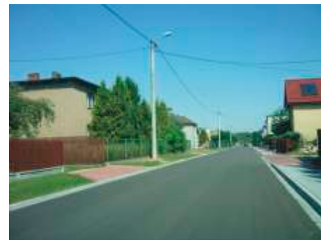
Ul. Ligonja po remoncie i zainstalowaniu lamp
