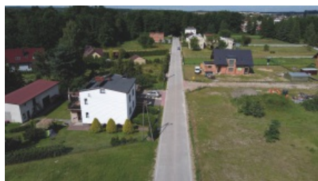
Przebudowa ulicy Młyńskiej w Boronowie
