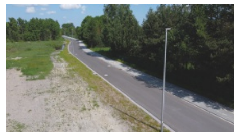
Budowa ulicy bocznej od ul. Wiśniowej w Boronowie
