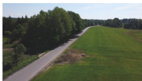
Przebudowa drogi w sołectwie Grojec
