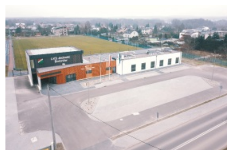
Budowa zaplecza LKS
