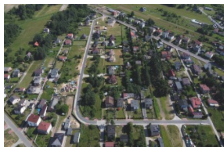
Budowa i przebudowa ul. Pogodnej i Powstańców Śląskich w Boronowie
