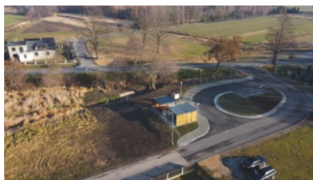
Przebudowa przystanku autobusowego w Hucisku wraz z funkcją obsługi turystycznej
