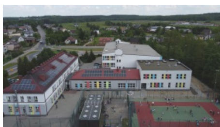
Kompleksowa termomodernizacja budynku Zespołu Placówek Oświatowych im. Unii Europejskiej w Boronowie
