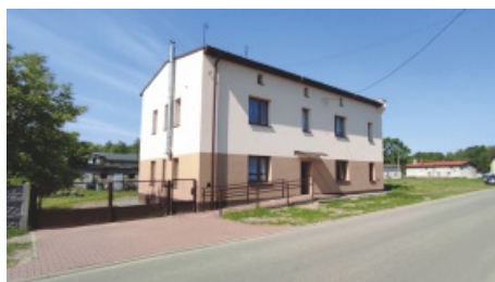
Termomodernizacja budynku komunalnego ul. Powstańców 9 w Boronowie
